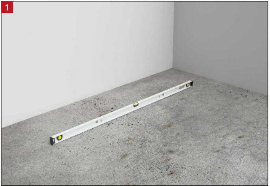
Der Untergrund muss ausgehärtet, sauber und trocken sein und falls erforderlich sollte eine passende Ausgleichsmasse aufgetragen werden, um eine glatte Oberfläche zu erhalten.
