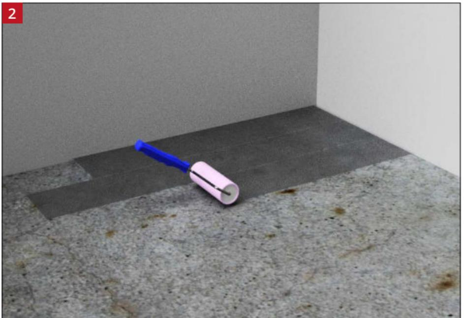
Den Untergrund mit einer verdünnten (1:4) SBR-Lösung grundieren. Bei speziellen Untergründen folgen Sie den Herstelleranweisungen.
