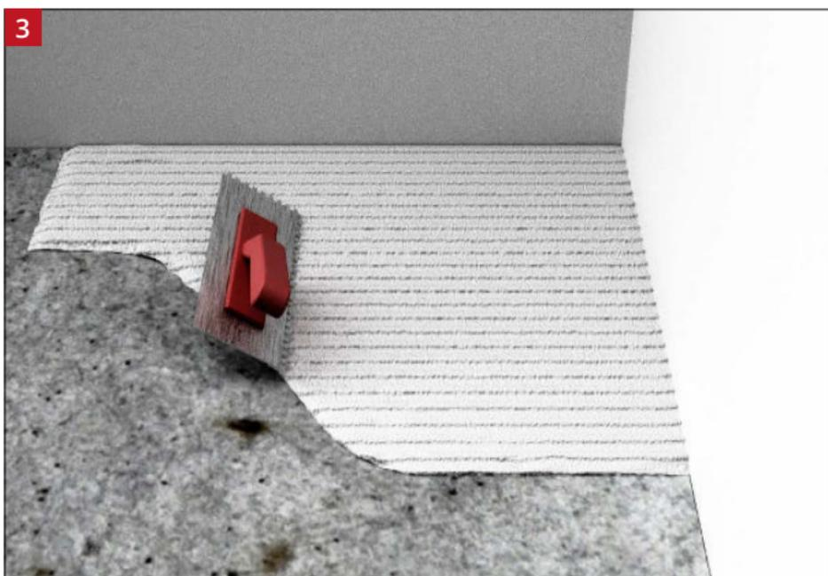
Die Warmup Ultralight sollte mit einem flexiblen, zementbasierten Kleber installiert werden. Der Kleber ist mit einem 6 mm x 6 mm (¼" x ¼") Zahnschachtel aufzutragen und zu verteilen, um eine gleichmässige Kleberschicht zu gewährleisten.
